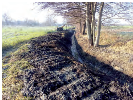
Fot. 2. Konserwacja rowu melioracyjnego RZSW w Trzebnicy [30] (autor: G.Górnicki)
