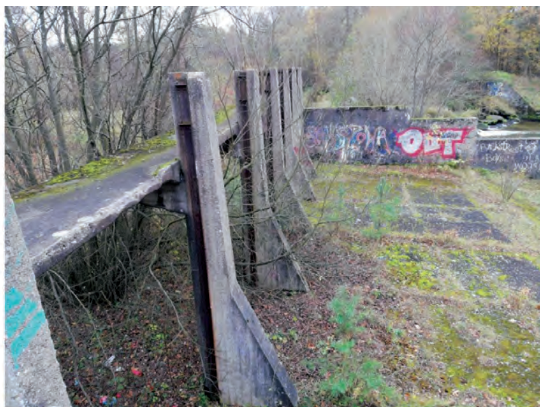
Fot.3. Stan jazu na Kwisie w miejscowości Ławszowa w październiku 2021. Widok pozostałości piętrzenia i przelewu na prawym brzegu rzeki (autor Mirosław Ryś)
