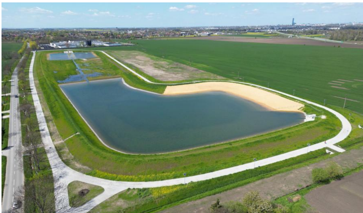
Rysunek 3. Widok zbiornika Smardzów na rzece Brochówka, gmina Siechnice, województwo dolnośląskie [10] (fot. Mat. prasowe UM w Siechnicach)
