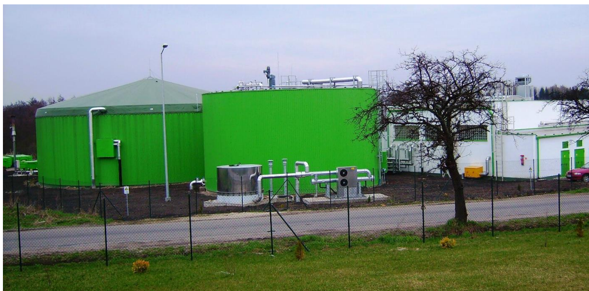
Fot. Biogazownia w Skrzatuszu; Foto. R.Targosz
